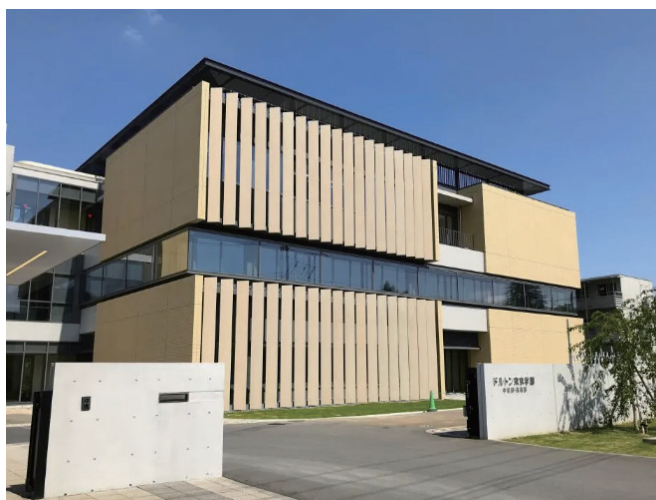
ZEB・STEAM 校舎プロジェクト / 校舎外観 (提供: 河合塾) ※ ZEB (Net Zero Energy Building) : 年間の一次エネルギー消費量の収支をゼロとすることを目指した建築物
